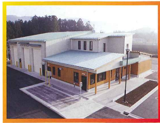
原料受入棟及び管理棟
