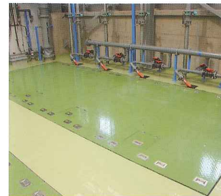
■硝化槽 排水は、酸素と微生物により、BODやアンモニアなどが分解され膜分離処理されます。透過水は、SSを含まない処理水となります。
