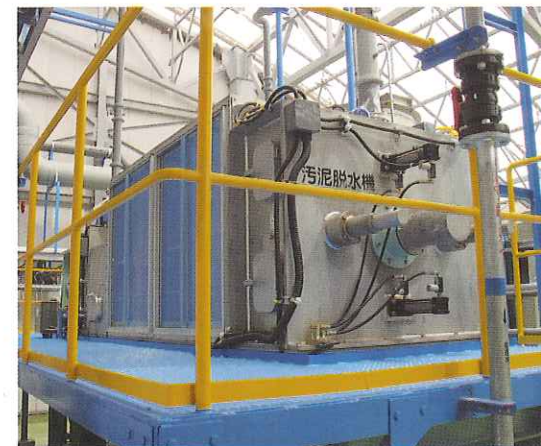
■汚泥脱水機 メタン発酵後の汚泥を薬品で凝集し、脱水します。
