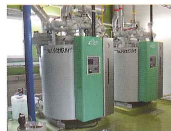
■バイオガスボイラ メタン発酵槽より発生したバイオガスを蒸気に変換します。
