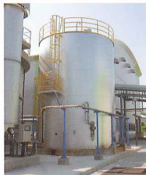
■ガスホルダ 発生したバイオガスは脱硫塔を通過してガスホルダに一時貯留されます。
