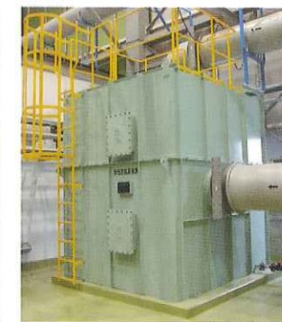
■活性炭脱臭装置 活性炭により、かすかな臭いも吸着します。
