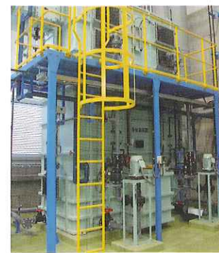
■薬液脱臭装置 臭いの成分を化学的に分解します。
