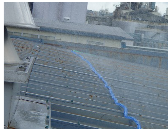
散水による気化熱利用
