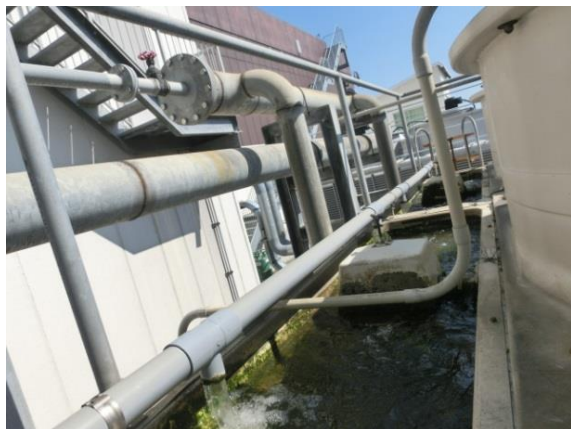
冷水塔冷却水一部取出と戻し
