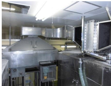
ダクト中間に設置したラジエータ
