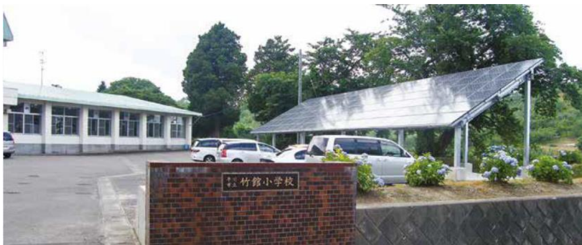
市内小中学校 13 校へ太陽光発電システムの設置
