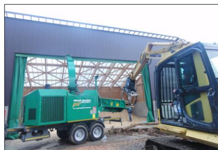
写真 2.3.3 木質チップ燃料製造施設
