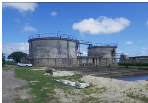
石垣市し尿処理場
