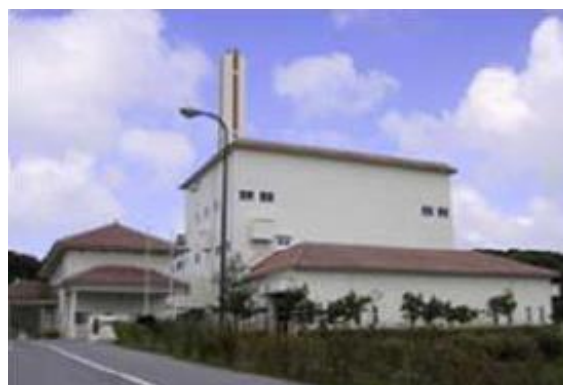
石垣市クリーンセンター
