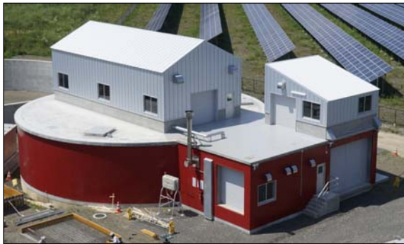
発酵槽・機械室
