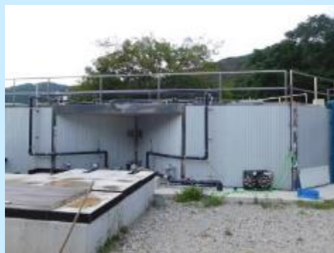
メタン発酵施設
