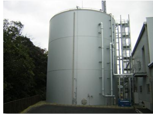
容量 2,300 m 3 のメタン発酵槽
