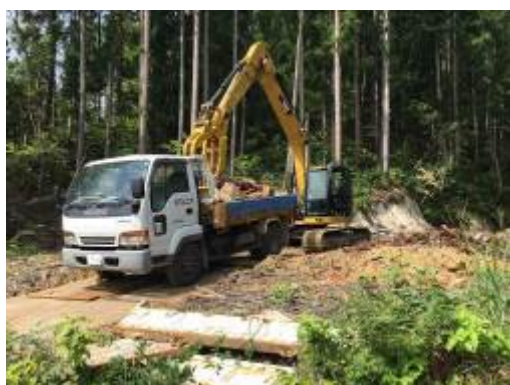
木材搬出試験の様子
