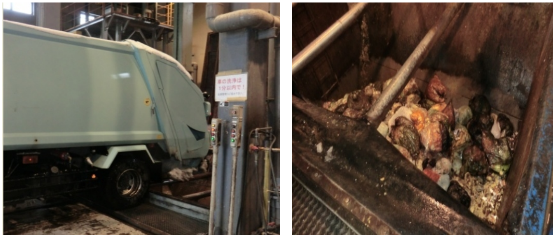
図 15 再生利用事業者のメタン発酵施設におけるパッカー車による食品廃棄物の投入(T社)
