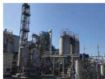
バイオエタノールプラント
