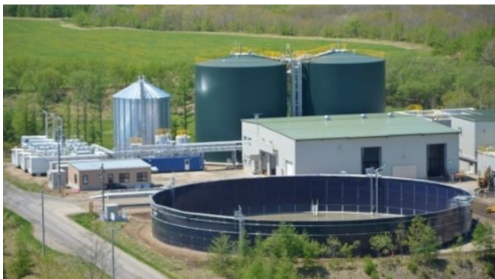
別海町バイオガスプラント
