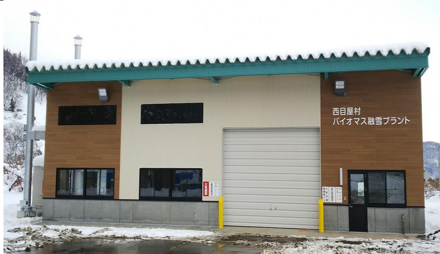
住宅団地熱供給施設
