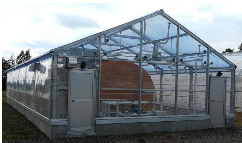
余剰熱供給施設
