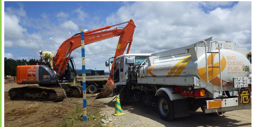
写真: 工事現場で重機への給油の様子
