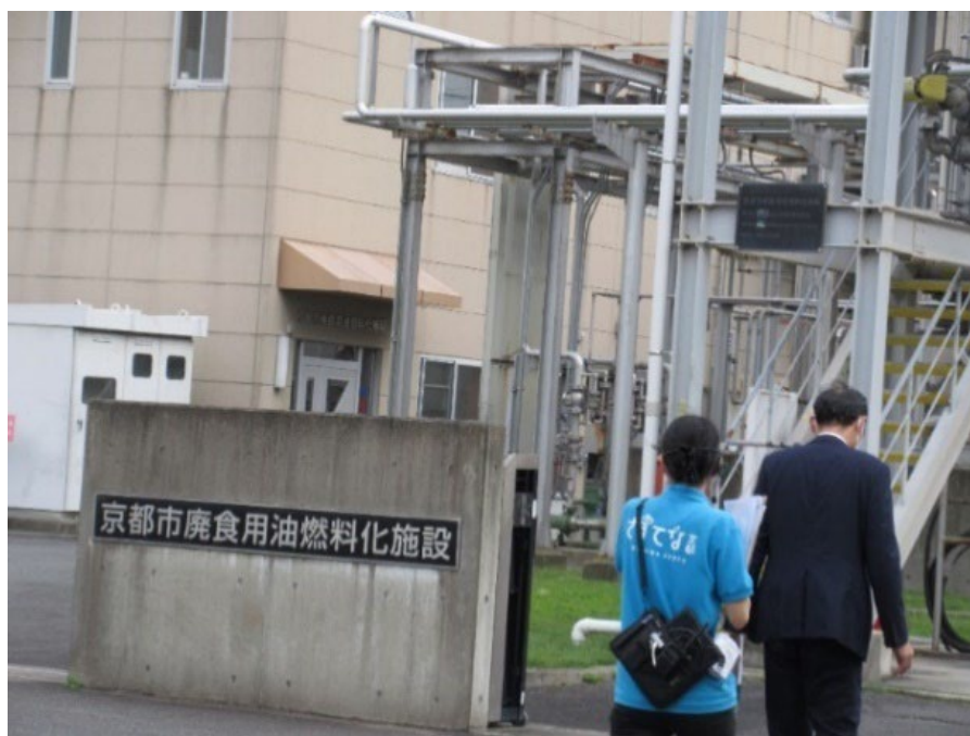
京都市廃食用油燃料化施設 入口
