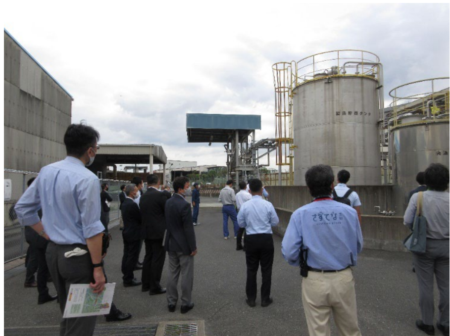
製品貯蔵タンク
