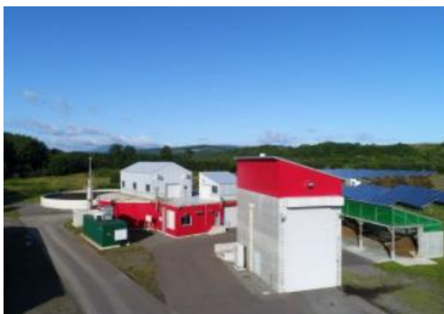
興部北興バイオガスプラント全景
