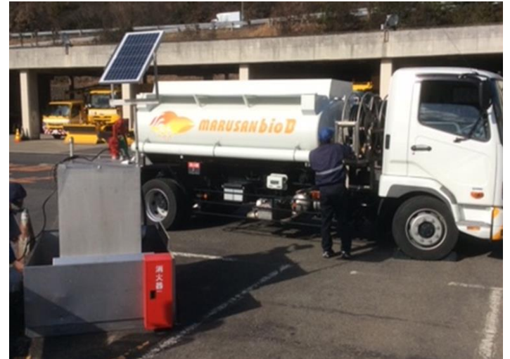
※車庫内にB5軽油給油機を設置
