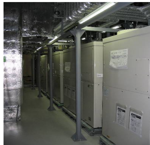
コ・ジェネガス発電機
