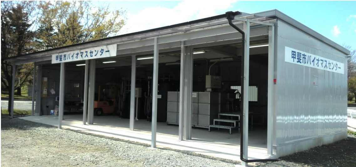
甲斐市バイオマスセンター
