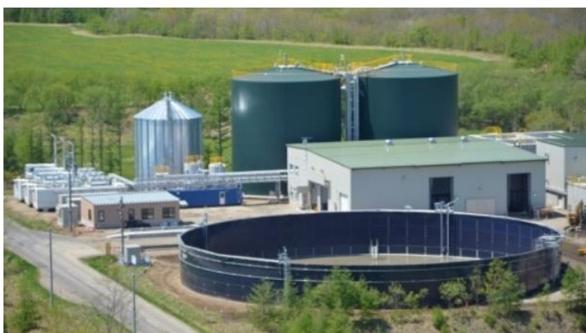
別海町バイオガスプラント
