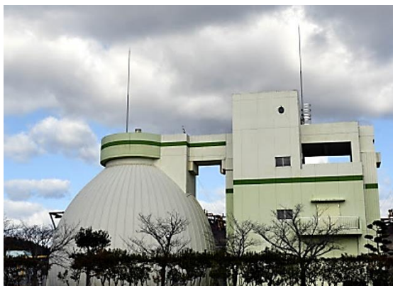
宗像最終処分場（消化タンク）
