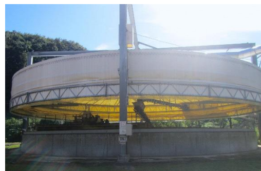
④円形発酵棟 (一次発酵棟)
