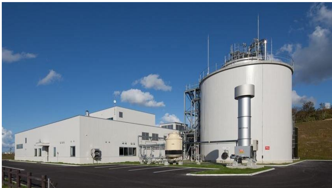
バイオエネルギーセンター 全景
